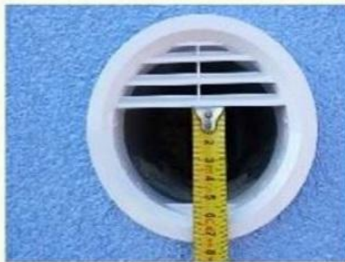
Obr. 7: Návrh zabezpečení a zateplení kruhových ventilačních otvorů v podstřeší.
